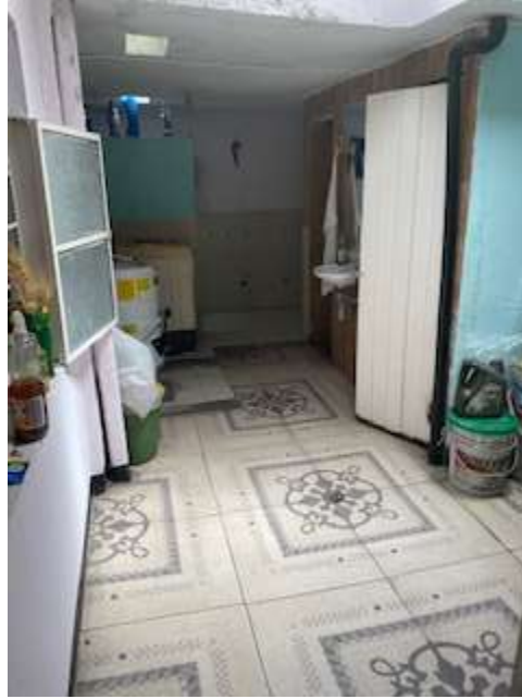
BAÑOS – PATIO INTERNO
